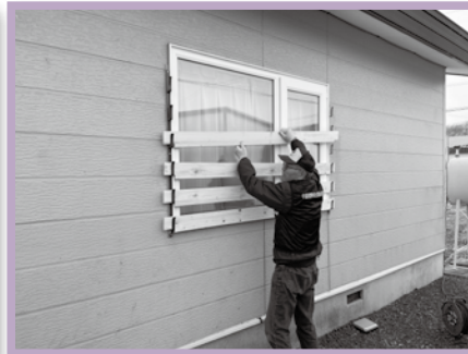
外窓の木枠取付
